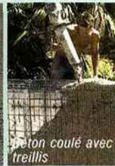
Béton à coulage perdu
