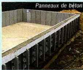
Béton à coulage perdu
