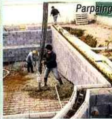
Béton coulé avec treillis
