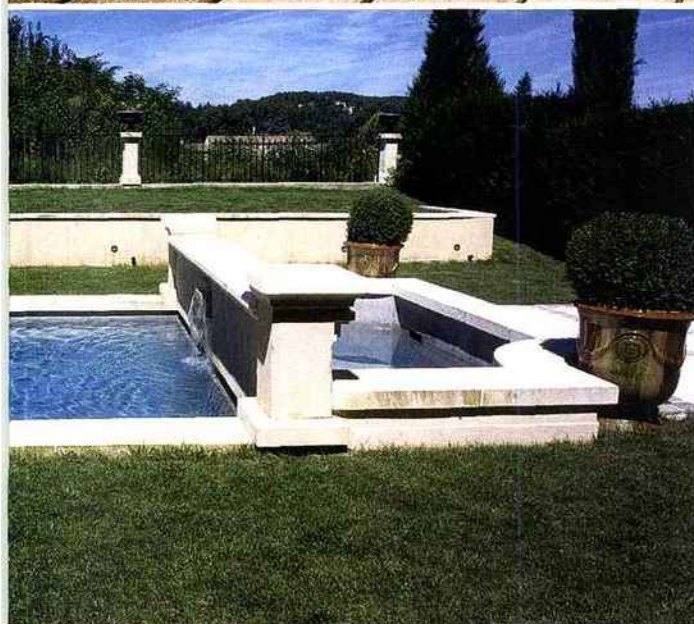
Ce bassin a été réalisé à l'aide d'un coffrage perdu breveté qui permet de réaliser toutes sortes de formes rectilignes ou courbes. L'Esprit Piscine.
