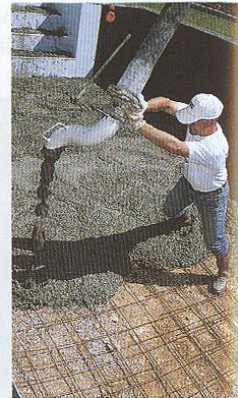
Le coulage du radier se fait à la suite du remplissage des murs.
