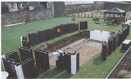
Les parois modulaires sont disposées autour du futur bassin.
