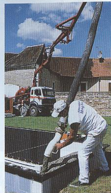
Le coulage du béton se fait en effectuant 2 ou 3 passages pour équilibrer les pressions dans les panneaux.
